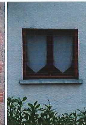
Baie 2e moitié du 20e siècle
